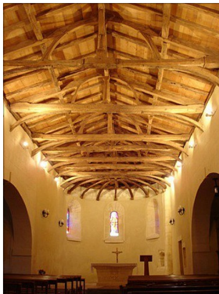
01/12 - La charpente de l'église de Magrigne
